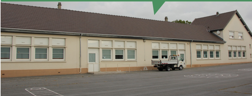
Réfection de la toiture-terrasse de l'école élémentaire Marie Curie (bâtiment Marie Curie 2).
