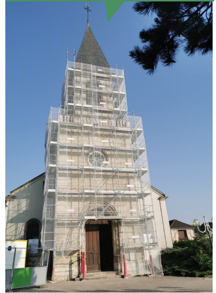
Rénovation de la façade principale de l'église Saint Jean Baptiste.
