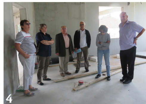
Visites de chantier du Groupe Scolaire Louise Michel
